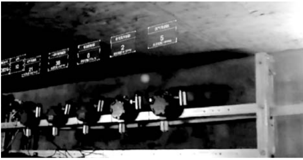
图 11 系统在武汉市黄家湖隧道中自动读取传感器数据
